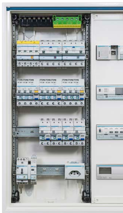
02 Rozmístění ochranných přístrojů
