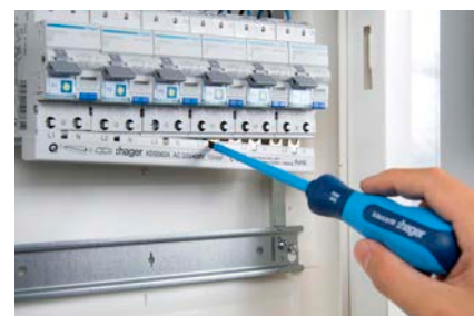
Fázová lišta lze snadno demontovat jednoduchým pákovým pohybem
